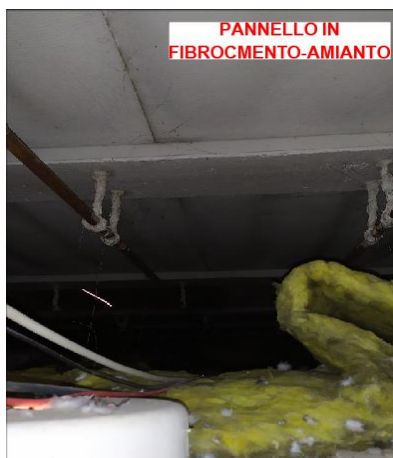
Figura 5: A sinistra fotografia nel controsoffitto della copertura con travi a Y, a destra fotografia del sottotetto della copertura a falde.
