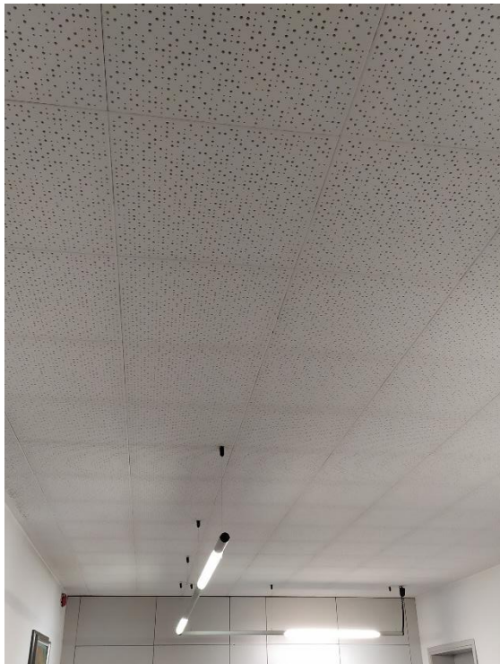
Figura 6. Fotografie del controsoffitto al piano primo da rimuovere
