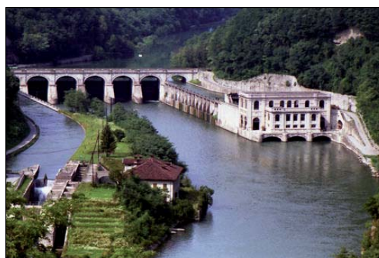
Figura 20 – centrale idroelettrica di Calusco e diga di Robbiate
