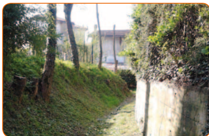
Un tratto dell'alveo del torrente Re, dopo la cura
