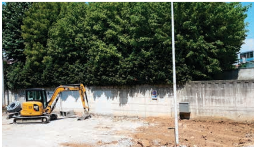
Lavori via Volmerange Les Mines (foto Brunella Brivio)
