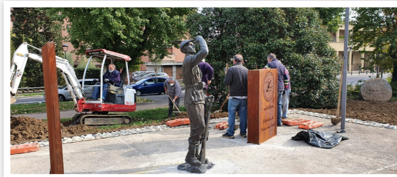
Lavori di ristrutturazione del monumento
