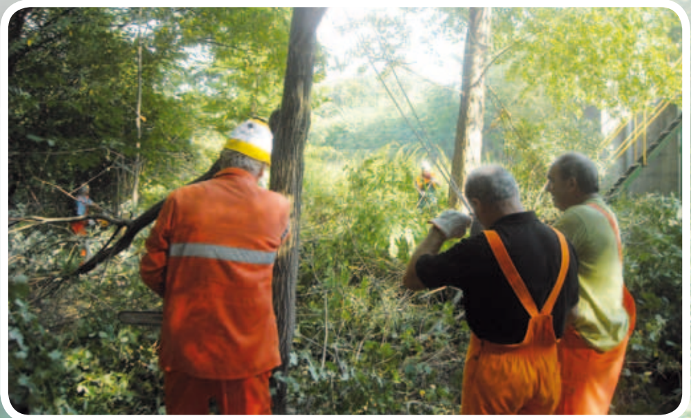
Durante i lavori
